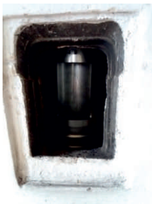
Osazení čistícího prvku
