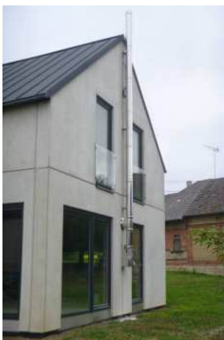
Založení pomocí konzole s dvířky
