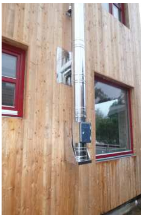
Založení pomocí konzole s dvířky
