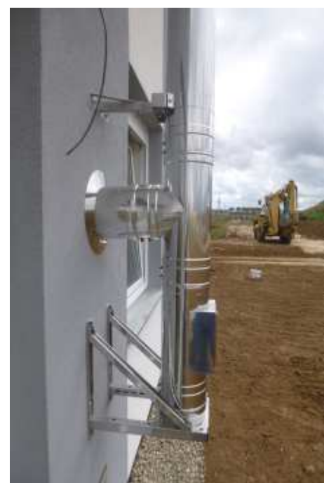
Založení pomocí stěnové vzpěry
