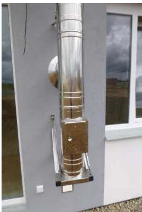
Založení pomocí konzole s dvířky
