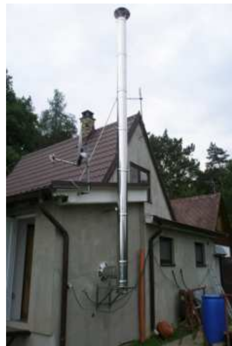
Upevnění vyšší nadstřešní části
