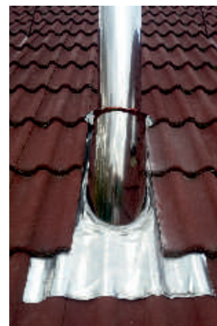
střešní olověné oplechování
