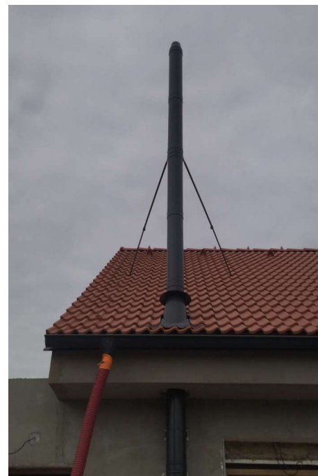
Upevnění vyšší nadstřešní části
