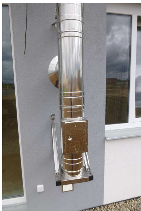
Založení pomocí konzole s dvířky
