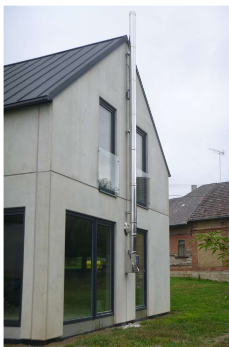
Založení pomocí konzole s dvířky
