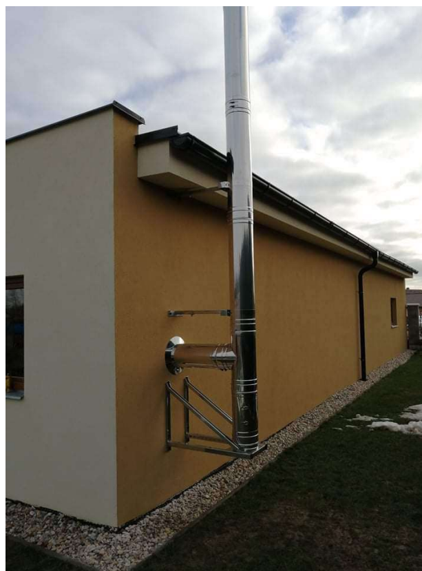
Upevnění pomocí delších držáků a konzole
