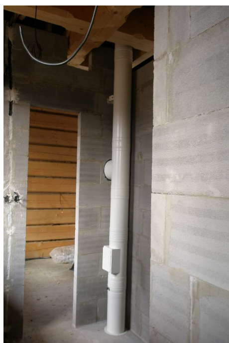
Založení na teleskopickou vzpěru
