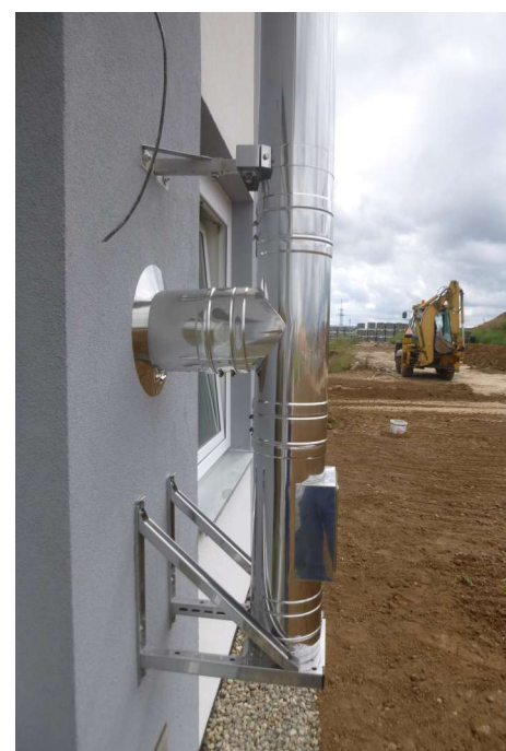
Založení pomocí stěnové vzpěry
