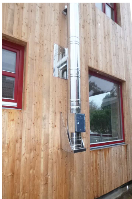
Založení pomocí konzole s dvířky
